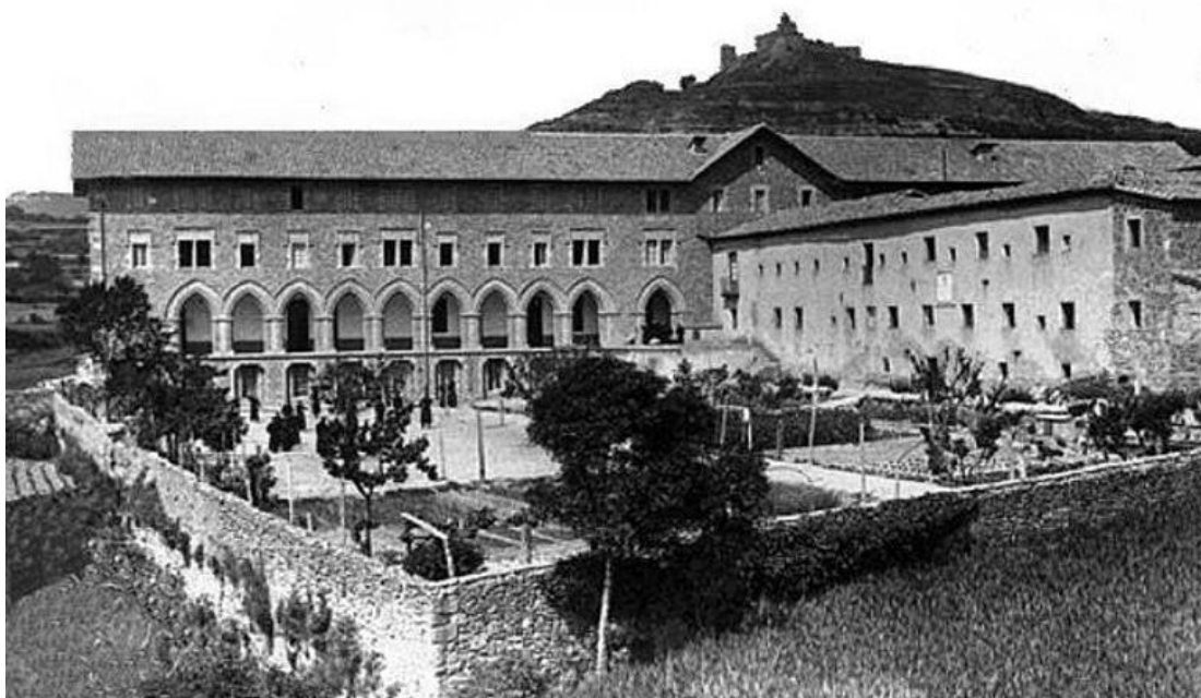
Convent dels Claretians. Aquest notable edifici estava annexat a l'antic convent els Caputxins, actualment seu de la parròquia de la ciutat. A la pàgina següent . Obres de construcció del convent, destaca la portada que s'aixeca al cantó de llevant. ARF
