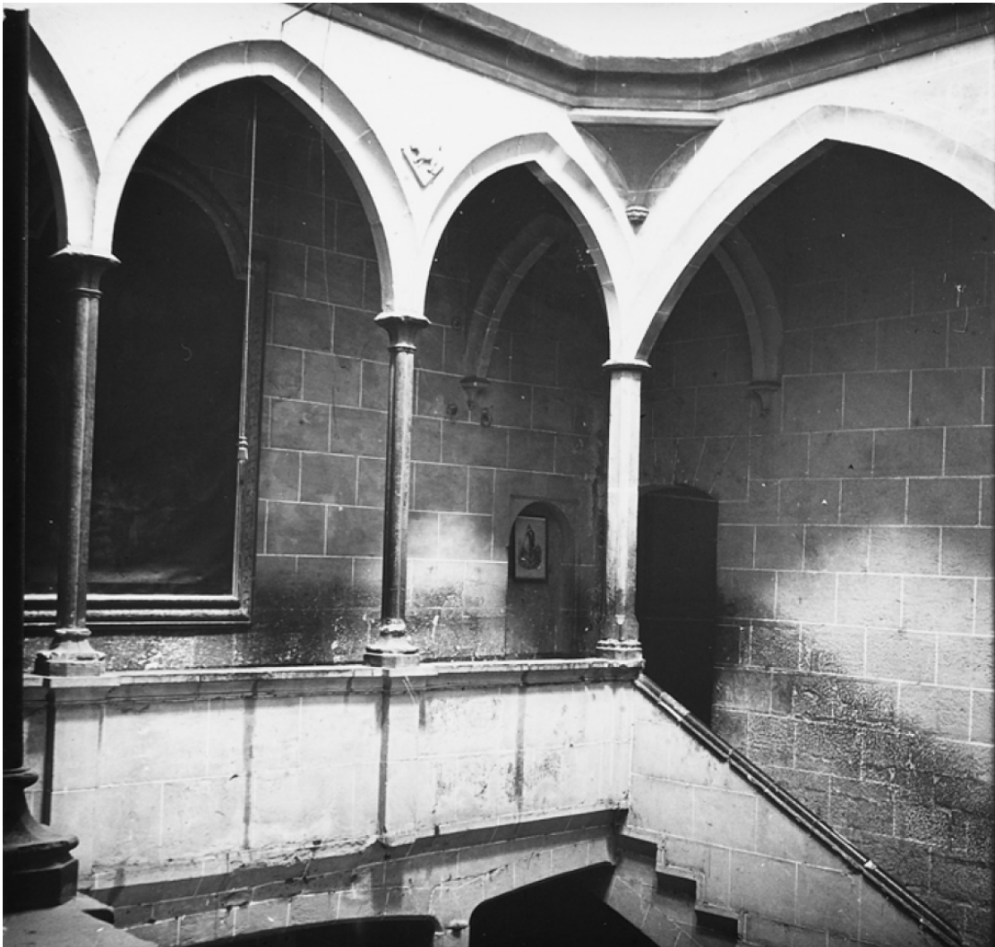
Pati de l'Hospital Llobera. Aquesta edifici ha acollit durant segles la Universitat Literària, el Seminari i les escoles parroquials. Representa un dels millor exemplars de gòtic civil. Es poden observar els escuts de la promotora de l'edifici Francesca de Llobera. FFS
