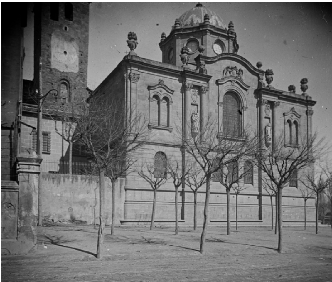
Façana del Cambril. Vista des del Vall Calent, la planta baixa correspon a les dependències de la Confraria del Claustre i la primera planta a la Capella. FFS
