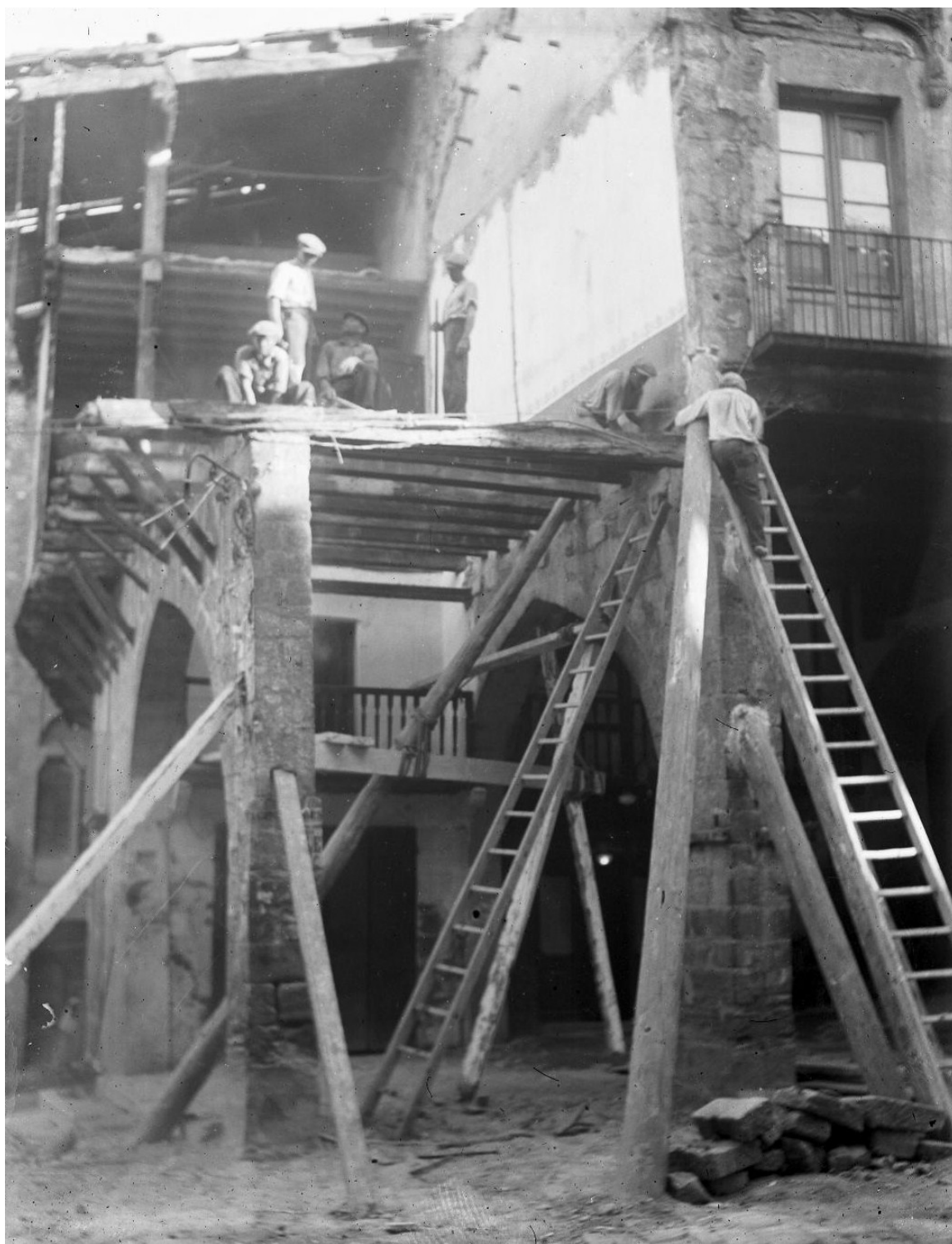
Casa Solé Xarpell. S'observa l'entramat de bigues dels dos pisos i la coberta. Aquest sistema constructiu es repetia en la majoria d'edificis d'aquella època i l'amplada de façana coincidia amb la llargada de les bigues de fusta. ACS-FV
