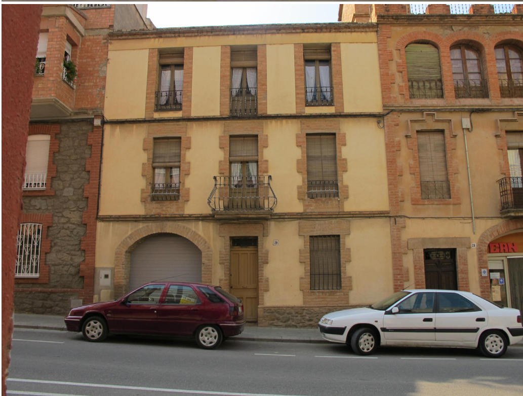
La Casa Bajona, el mateix edifici es va reproduir a la casa de l'esquerra
