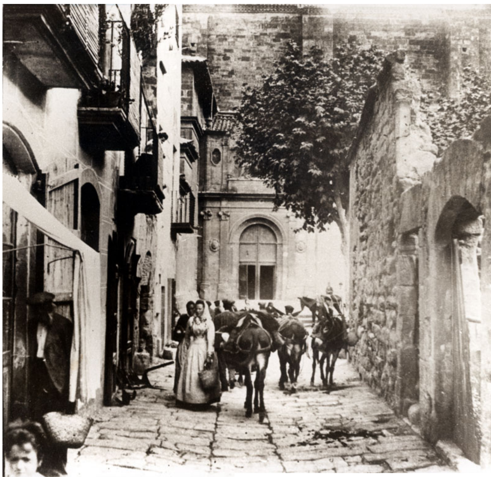
Carrer Sant Llorenç abans de la restauració.
