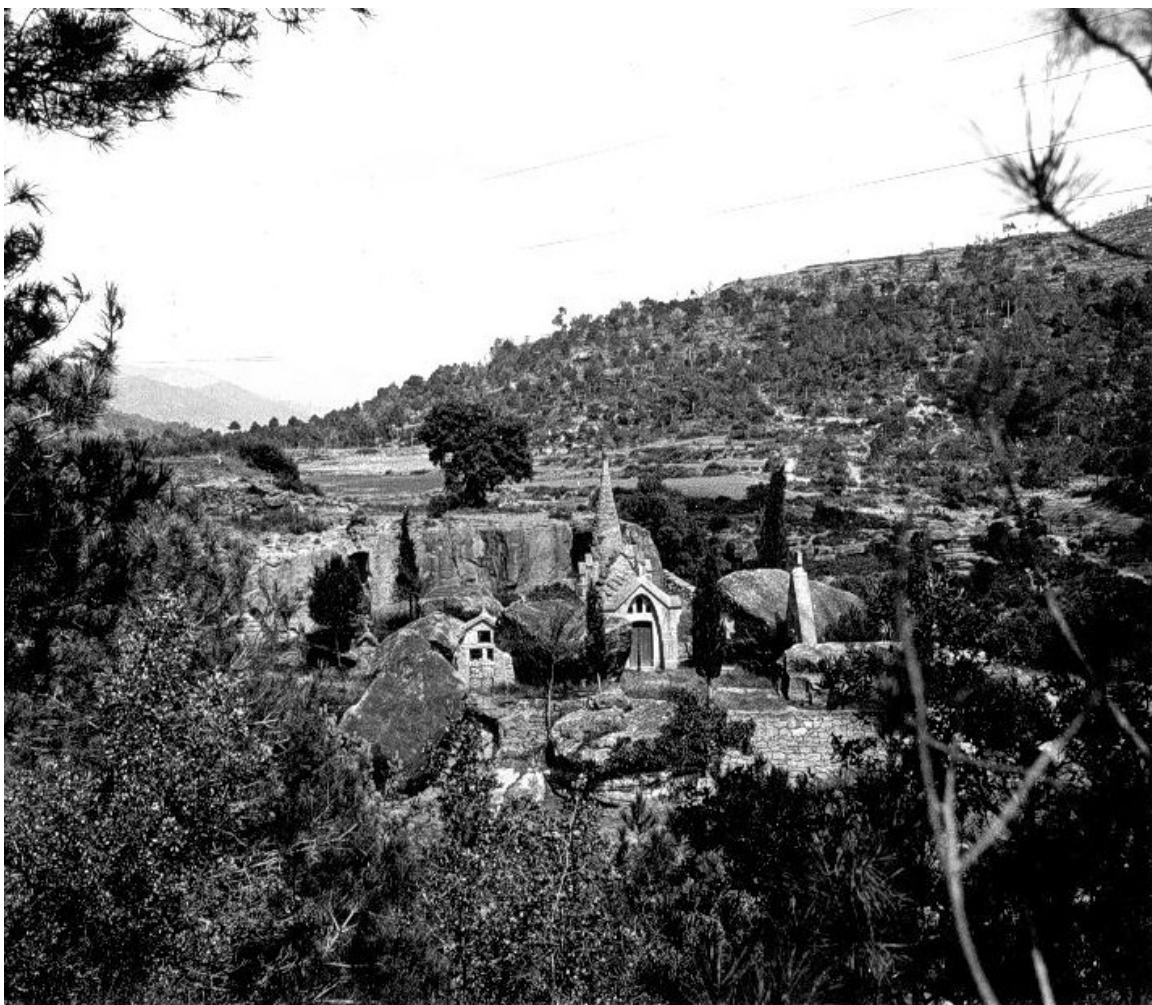
Cementiri d'Olius. Les característiques d'aquesta obra la fan un exemplar únic dins el panorama arquitectònic català. ACS-FV
