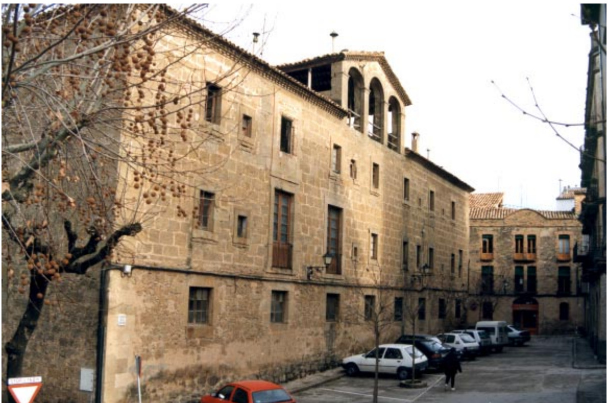
Fotografia realitzada pocs dies abans de l'enderroc
