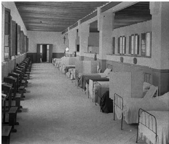
Habitacions del Seminari; es pot veure la solució constructiva per substituir les bigues de fusta per unes de ferro. ACS. Arxiu Vicens
