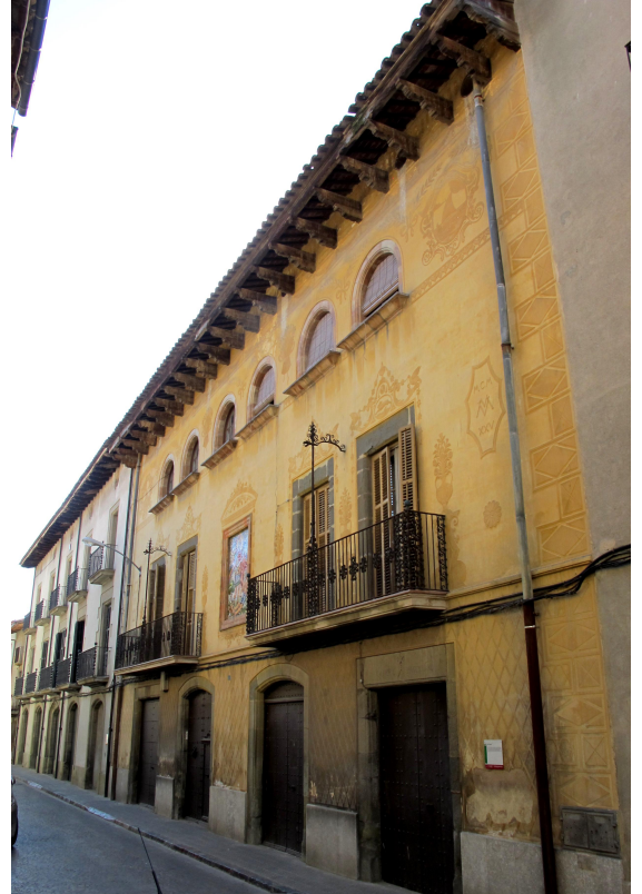
Façana de la Casa Vilaseca. Podem observar l'esgrafiats del conjunt i els balcons de forja que Puig Boada treballava amb tots els detalls.
