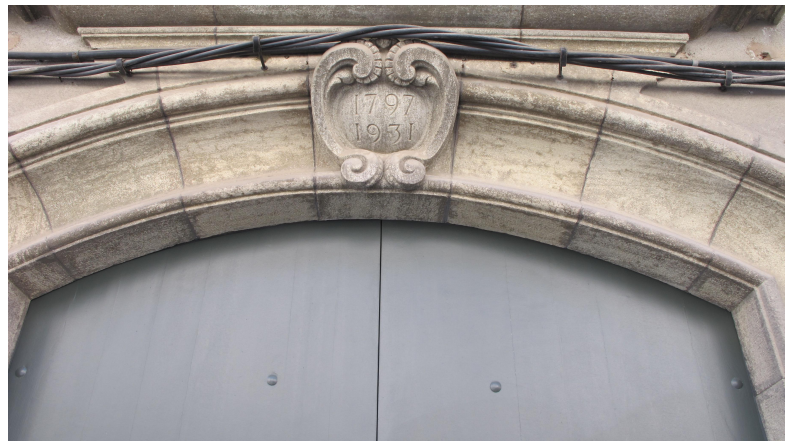
Imatges actuals de la casa Sanglas. A dalt, vista general de l'edifici, al fons es pot observar la Casa Vilaseca. A baix, escut central de la porta principal on es pot llegir la data de l'edifici i la restauració.
